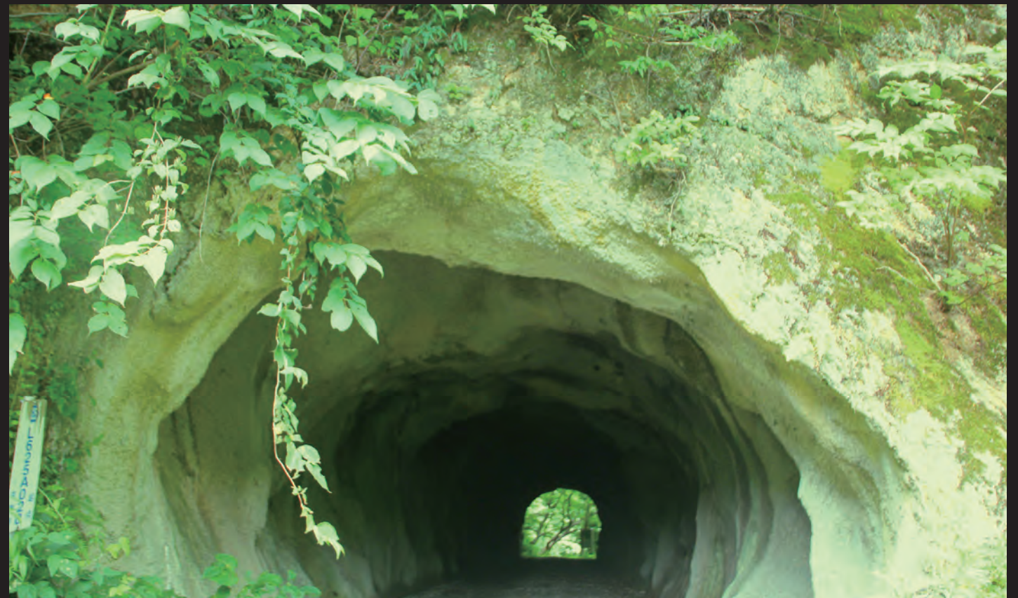
⑳「須川の手掘りトンネル」(弥栄町) / P27 D-2 昭和14年に掘削された全長約35m、幅2.5mの手掘りトンネル。トンネルの出口からは四季折々の彩りを眺望することができます。
